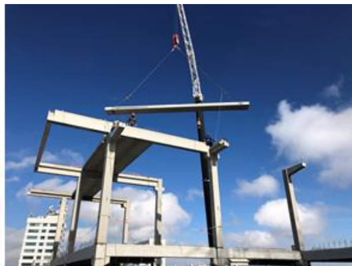
Figuras 98, 99 e 100: Heliporto executado com estrutura pré-fabricada.
