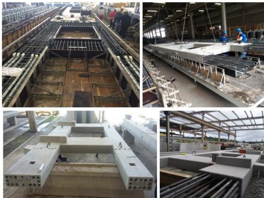
Figuras 16, 17, 18 e 19: Processo de fabricação dos “pilares H”.
