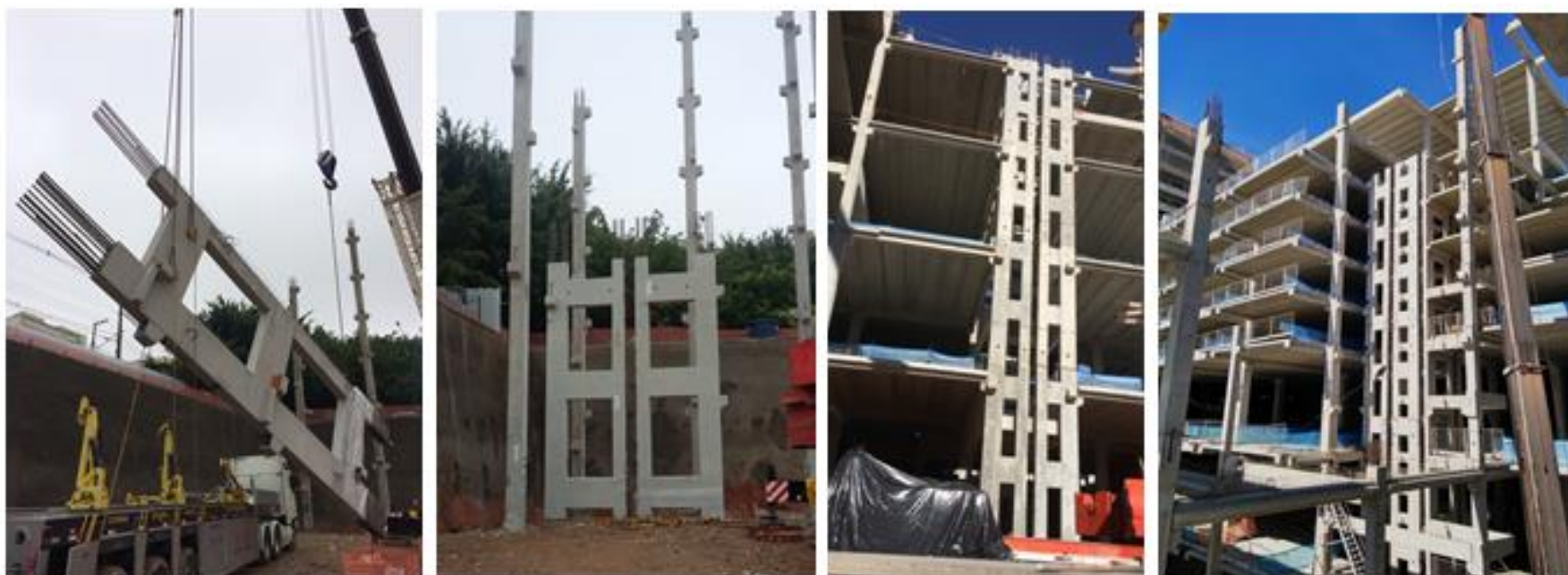
Figuras 20, 21, 22 e 23: Processo de montagem dos “pilares H”.
