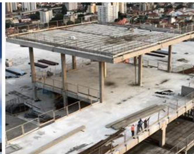
Figuras 98, 99 e 100: Heliporto executado com estrutura pré-fabricada.
